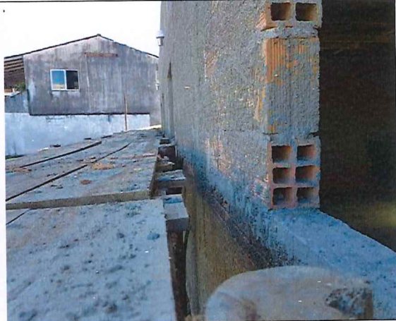
No outro lado existe contraverga, assim como nas demais janelas
