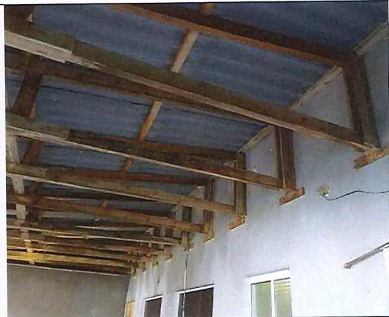
Estrutura do telhado
