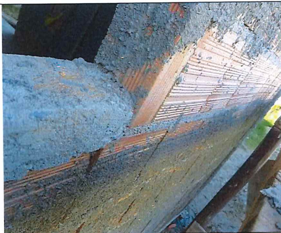
Vista do local sem a contraverga - externo
