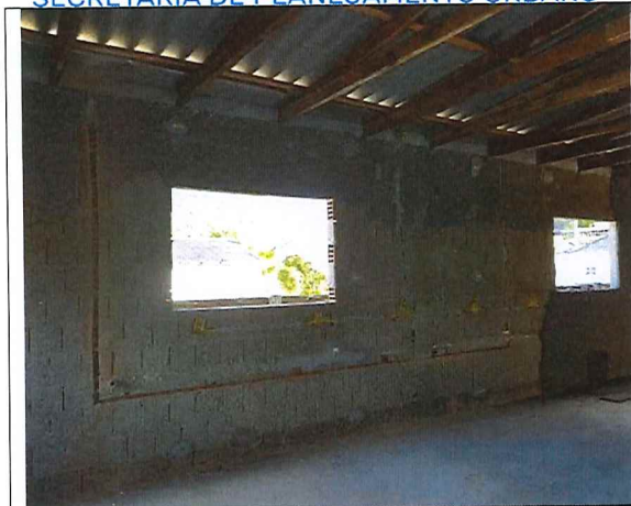
Corte para instalações
