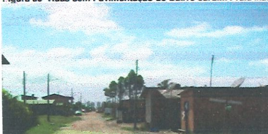
Figura 36- Ruas sem Pavimentação do Bairro Jardim Praia Mar
